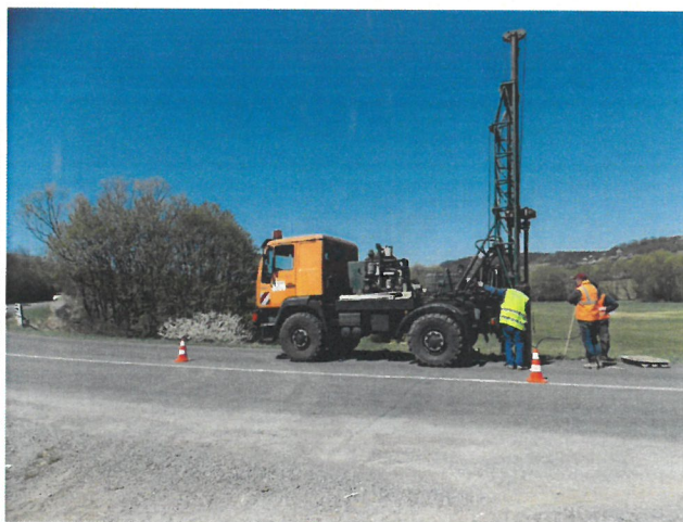
Obrázok 13 Vŕtanie sondy pri moste na ceste II/527
