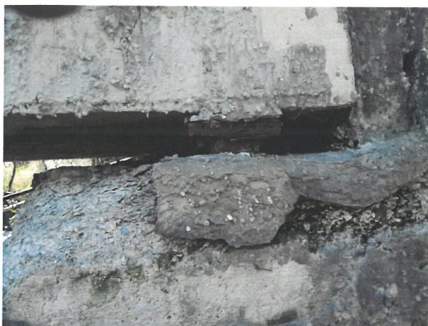
Obrázok 10 Rozpad betónu na úložnom prahu a korózia ložísk
