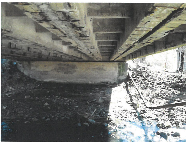
Obrázok 8 Pohľad na oporu od Senohradu a nosnú konštrukciu Obrázok 9 Rozpad betónu na krídlach
