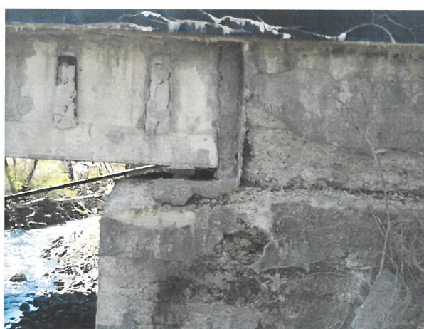
Obrázok 8 Pohľad na oporu od Senohradu a nosnú konštrukciu Obrázok 9 Rozpad betónu na krídlach
