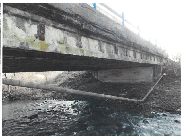
Obrázok 7 Pohľad na nosnú konštrukciu mosta na výtoku
